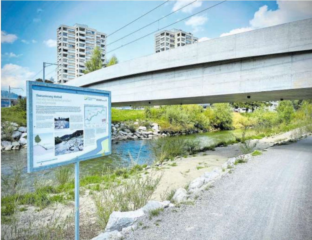
Die geplante Thuranterung weckte viele Emotionen: Sie wurde mehrfach scharf kritisiert; wegen des Landverschleisses und der Fällung von rund 400 Bäumen entlang der Thur, aber auch wegen der massiv gestiegenen Projektkosten. In einer Broschüre vom Mai wurde das Projekt plötzlich auf 110 Millionen Franken geschätzt statt wie bisher auf 50 Millionen Franken. Fortsetzung folgt. Bild: Alain Rutishauser
